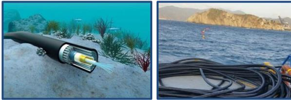
Ilustración 17. Estructura Cable Submarino (Izquierda) – Maniobra Instalación Cable Submarino Isla el Morro Santa Marta. (Derecha).
