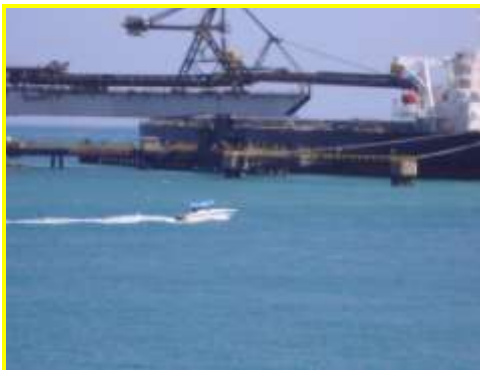
Foto 13.: Inspección MN TOP RICH 23 de marzo 2011.
