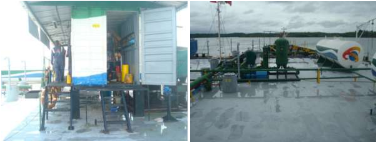
Inspecciones a Estaciones Flotantes en la Bahía de Buenaventura
