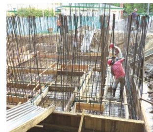
▲ Construcción de la Estación de Control de Tráfico Marítimo en Turbo, Antioquia.
