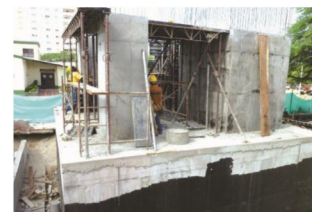
▲ Construcción de la Estación de Control de Tráfico Marítimo en Santa Marta, Magdalena.
