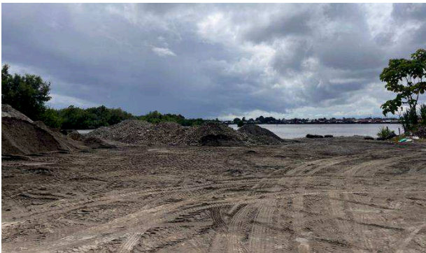
Imagen No. 4 Acopio de material de cantera sobre el área inspeccionada.
