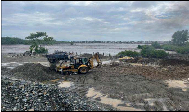
Imagen No. 2 Actividades de cantera sobre el área inspeccionada.
