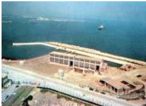
Figura 19 Una toma de agua de mar / descarga de aguas residuales
