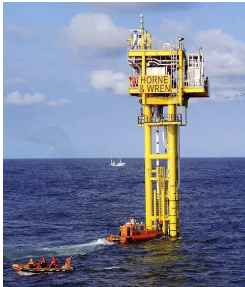
Figura 13 Un ejemplo de una plataforma de instalación mínima
