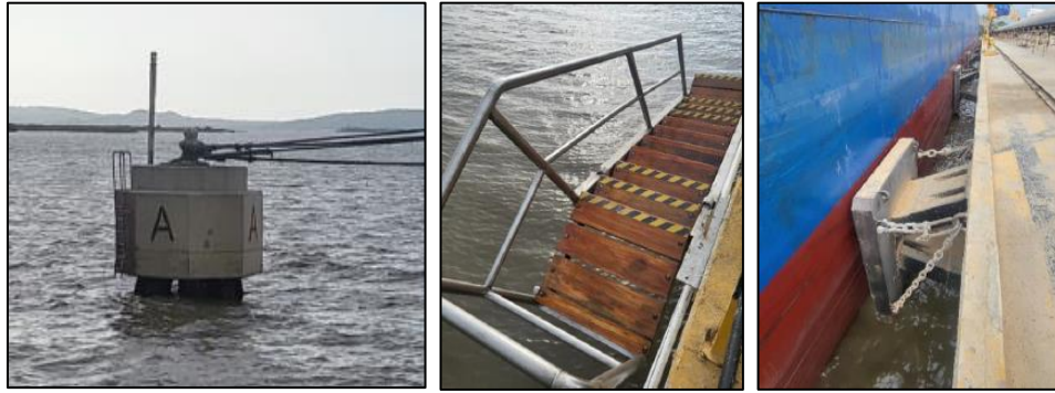
Ilustración 87. Visitas de seguridad integral marítima CP03. Fuente: Fotografía propia proceso M6
