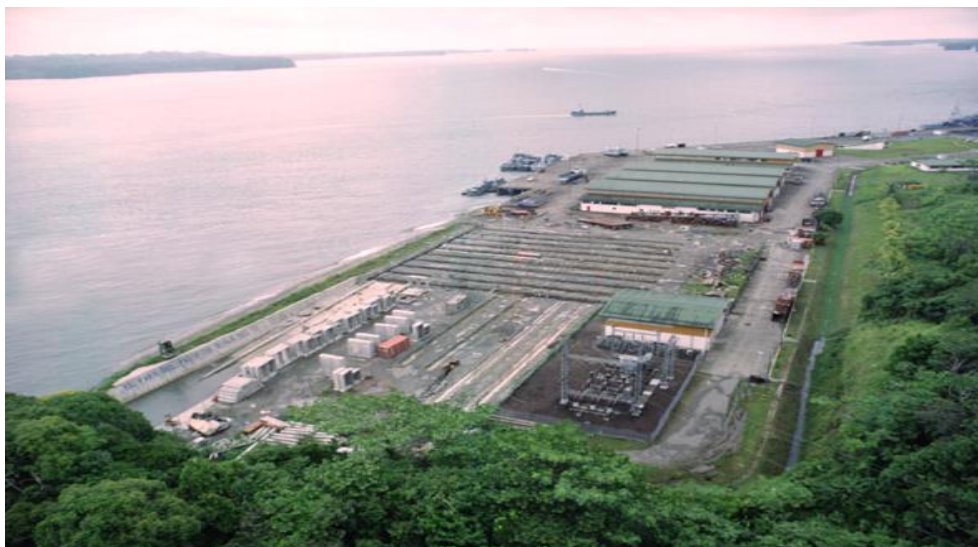
Construcción del Varadero de la Planta Málaga
