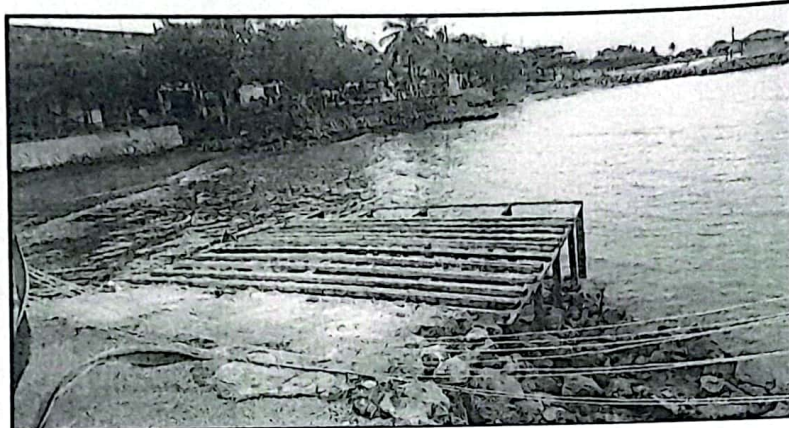
Foto No.3 Vista de la construcción de un embarcadero
