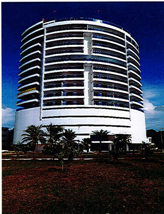
Figura 2. Vista general de la edificación.
