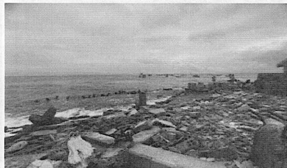
Foto 7. Relleno de residuos especiales de construcción.
