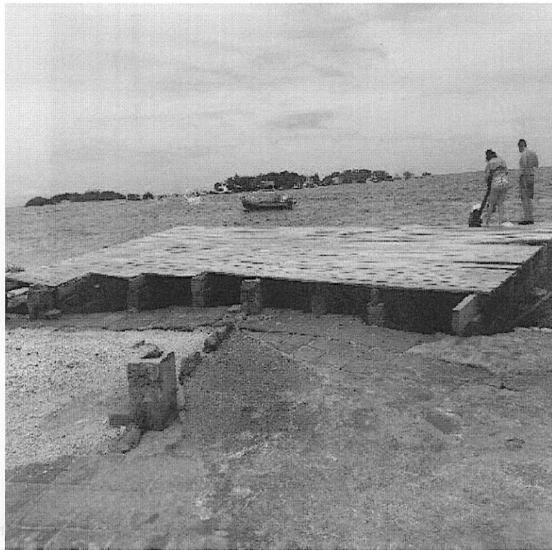
Imagen No 1. Vista general del área donde se localiza el muelle 1.
