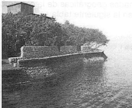
Imagen No 7. Vista lateral de la protección costera.
