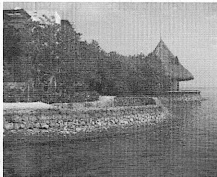
Imagen No 6. Vista lateral de la protección costera.
