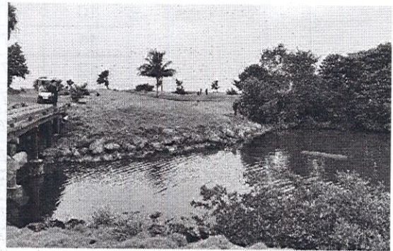
Imagen 40. Enrocado del puente 5
