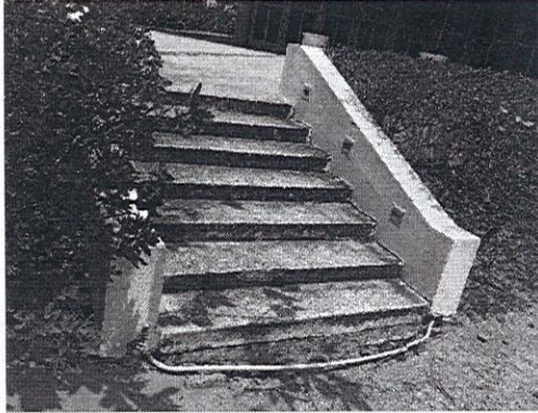
Imagen 19. Escaleras de concreto
