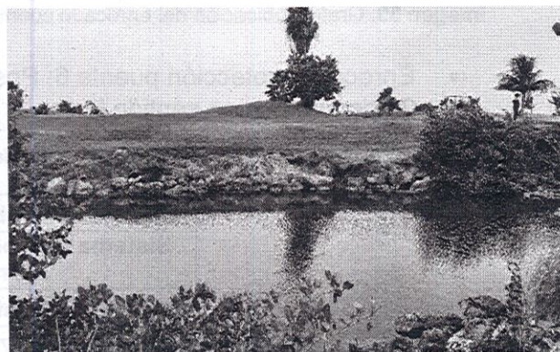
Imagen 38. Enrocado del puente 4
