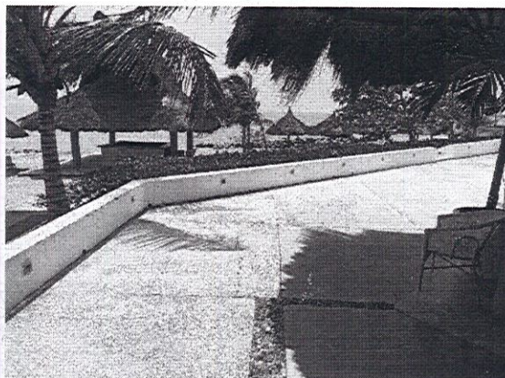
Imagen 30. Muros en concreto.
