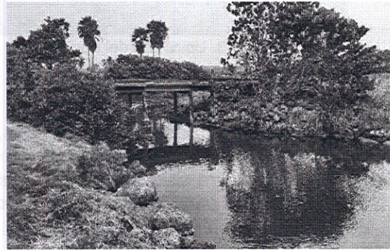
Imagen 42. Enrocado del puente 6
