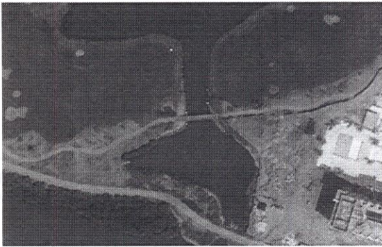
Imagen 41. Ubicación enrocada el puente 6
